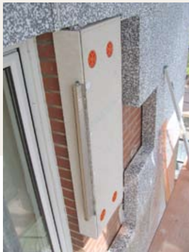
Lunos: Installation eines Lunotherm und Thermografie bei einer Fassade im Wärmedämmverbundsystem. Die maximale Temperaturdifferenz von 2 bis 3 K zwischen Hinterlüftung und Fassade ist unkritisch.
