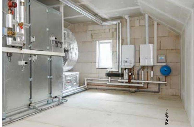
Dachheizzentrale des Gasthauses. Links die RLT-Anlage mit Wärmerückgewinnung, im Hintergrund die ecotec-Gas-Brennwertgeräte mit je 65 kW in Kaskadenschaltung für die Wärmeversorgung der Lüftungsanlage und zur Nachheizung des Pufferspeichers im Gasthaus.
