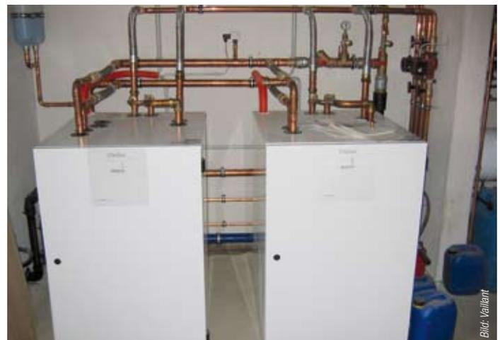
Die „geotherm pro“-Erdwärmepumpen, mit je 44 kW Leistung in Kaskade geschaltet, arbeiten bedarfsabhängig einzeln oder in Kombination.
