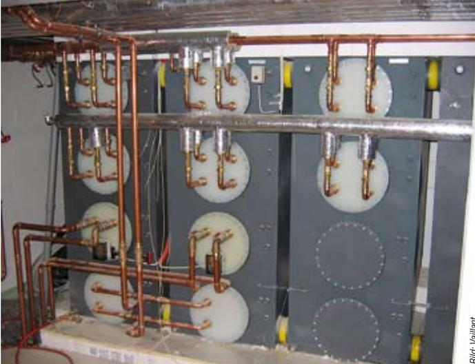
Pufferspeicher, hier mit zehn einzelnen, beispielsweise zu Wartungszwecken zu entnehmenden Wärmeübertragern. Über die vorgeschraubten Blindflansche können weitere Wärmeübertrager nachgerüstet werden.
