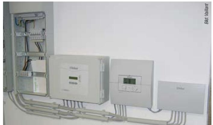
Ständig mit einem Außenfühler kommunizierend regelt der Energiebilanzregler die Temperaturen im Kreislauf der Erdwärmepumpen witterungsabhängig.
