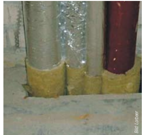
Bild 1 Links: Rohrleitungen im Null-Abstand. Wie soll hier eine Schalung erfolgen? Wie kann ein vernünftiger Deckenverguss eingebracht werden? Wie soll die geforderte Deckenhöhe eingehalten werden, wenn brennbarer Bauschaum den Raum ausfüllt? Rechts: Rohrleitungen in einer Reihe. Wie soll der Betonverguss hinter die Rohrleitungen gelangen?
