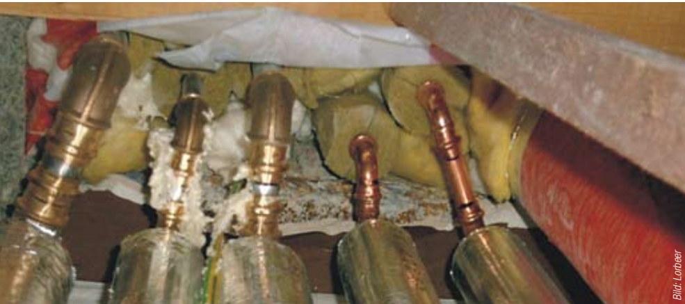
Bild 1 Links: Rohrleitungen im Null-Abstand. Wie soll hier eine Schalung erfolgen? Wie kann ein vernünftiger Deckenverguss eingebracht werden? Wie soll die geforderte Deckenhöhe eingehalten werden, wenn brennbarer Bauschaum den Raum ausfüllt? Rechts: Rohrleitungen in einer Reihe. Wie soll der Betonverguss hinter die Rohrleitungen gelangen?
