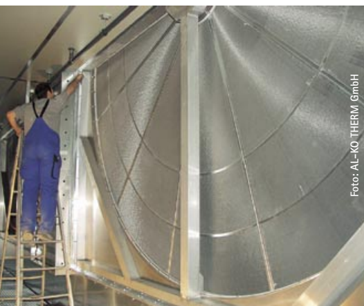
Bild 9 Rotationswärmeübertrager mit vollporiger, federnachgeführter Dichtung
