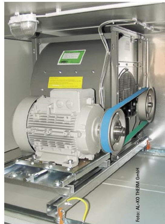
Bild 6 Flachriemenantrieb
