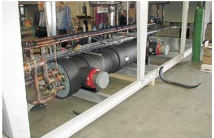
Europas größte Kältemaschine mit dem Kältemittel R 290 Propan stellt 1,2 MW Kälteleistung für die Raketenfertigung im Arianezentrum zur Verfügung
