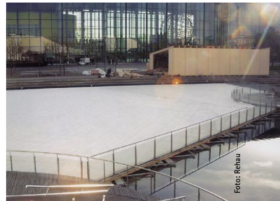
Mobile Eisflächenkühlung auf Holzkonstruktion
