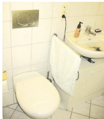
...modernisiert mit industriell vorgefertigten Installationswänden im bewohnten Zustand innerhalb weniger Tage
