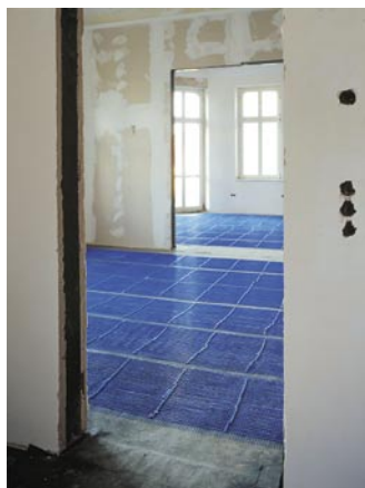
Polytherm: Kapillarrohrmatten für die „sanfte“ Renovierung
