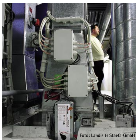
Bild 7 Lüftungsanlage mit LON-Box zur Ansteuerung der Brandschutzklappen
