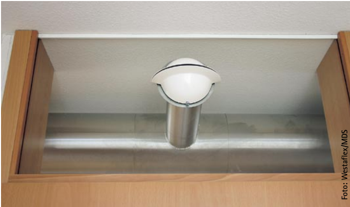
Bild 4 Anschlussdetail Oberlicht mit Weitwurfdüse. Die einzelnen Formteile sind über einen Innenstecker stumpf miteinander verbunden
