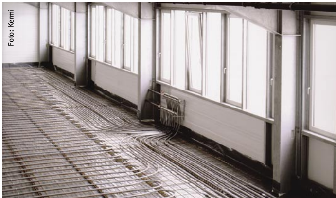
Foto: Kermi Kermit: xnet C14, Fußbodenheizung für Industrieböden und hochbelastbare Großflächen
