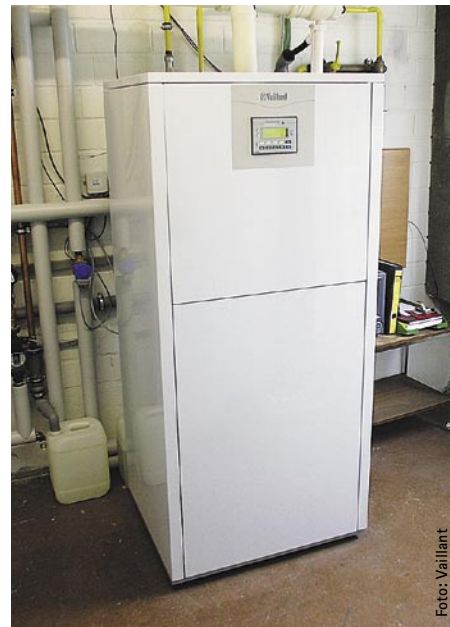
Zurzeit im Feldtest: Zeolith-Heizgerät
