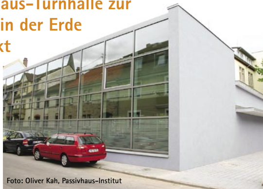
Nord- fassade der Turnhalle
