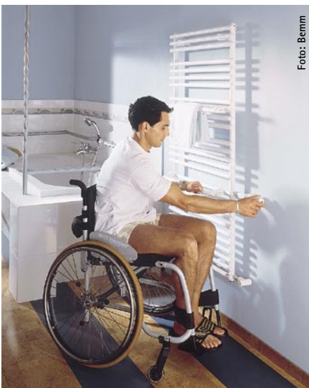
Bild 7 Richtig platziert: Thermostatventil in Bedienungshöhe (Bemm)
