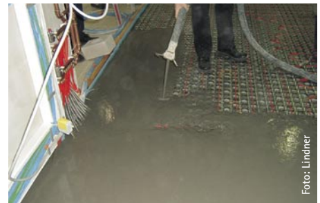
Der Estrich kann nach wenigen Stunden betreten werden
