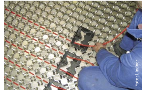
Einziehhilfe für das Kunststoffverbund-Heizungsrohr
