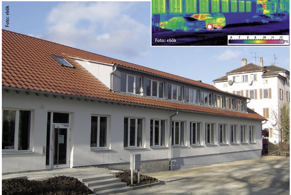
ebök-Büro nach der Sanierung. Es gilt als das weltweit erste sanierte Bürogebäude, das als Passivhaus zertifiziert wurde
