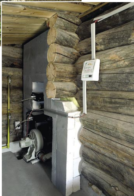
Die gesamte Technik eines Saunagasofens befindet sich wartungsfreundlich außerhalb der Saunakabine
