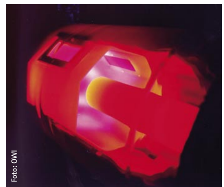
Bild 2 Stabilisierung der Flamme in einem Umkehreinsetz im Vorverdampfungsbrenner (Heizöl EL)
