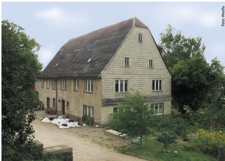
Das 200 Jahre alte Wohnhaus auf dem Bochmann-Hof. Das Sanierungskonzept verbindet moderne Technik und alten Stil
