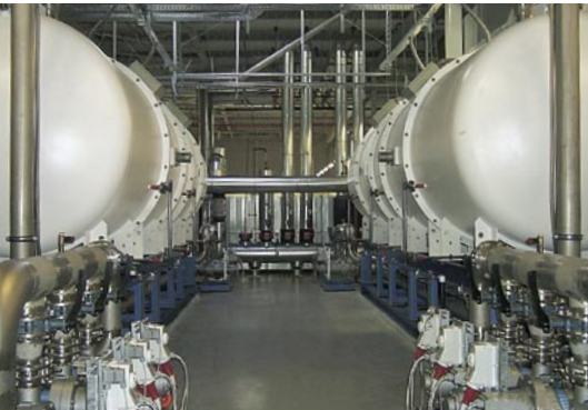
2 x R718-Turbo-KWS mit je 1 MW Kälteleistung
