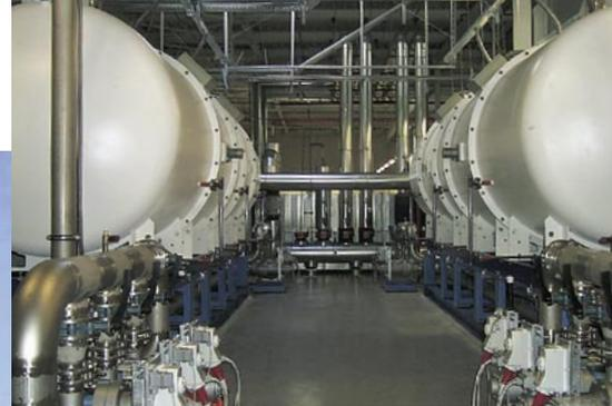
Bei VW in der Gläsernen Manufaktur Dresden (links), und bei DaimlerChrysler Düsseldorf (oben), und bei DaimlerChrysler Düsseldorf (oben) werden Aqua-Turbo-Kältemaschinen als Grundlast-Kälterzeuger eingesetzt
