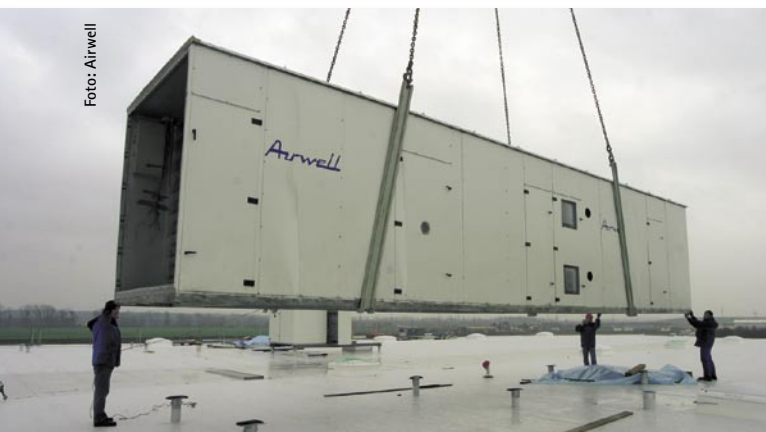
Montage einer 20 Tonnen schweren IPOC-Dachklimazentrale
