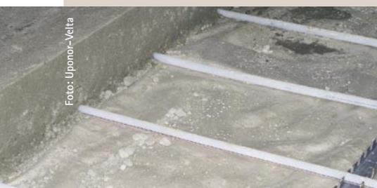
Sohlplatte aus Walzbeton mit PE-Xa-Rohren
