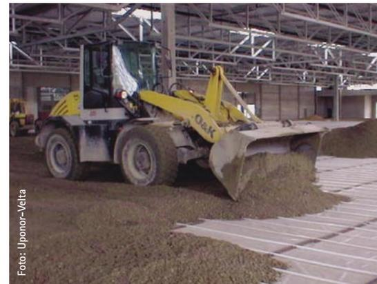
Radlader und Schleppgrader verteilen das Spezialbetongemisch auf der Heizebene
