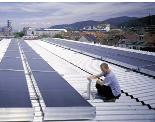
Solarluftkollektoren einer Sorptionsgestützten Klimatisierung (SGK)
