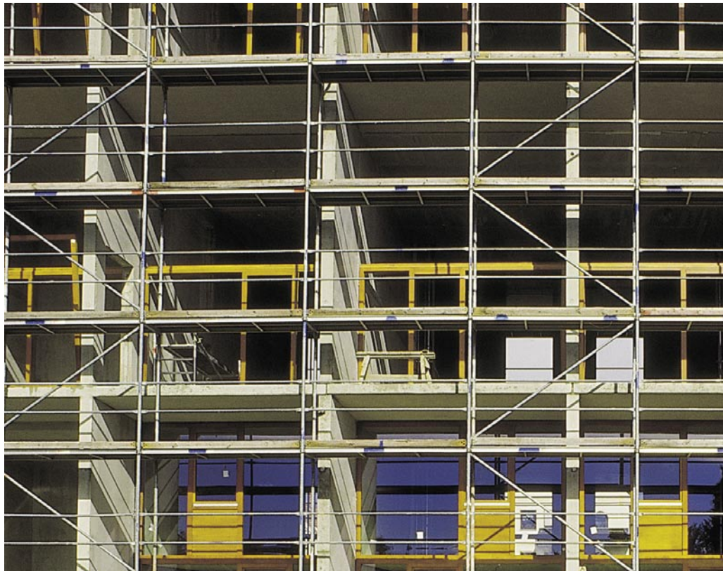
„Großbaustelle“ EU-Gebäuderichtlinie: Spätestens ab 2006 muss die Einsetzbarkeit alternativer Heizsysteme bei Neubauten über 1000 m 2 Nutzfläche vor Baubeginn berücksichtigt werden
