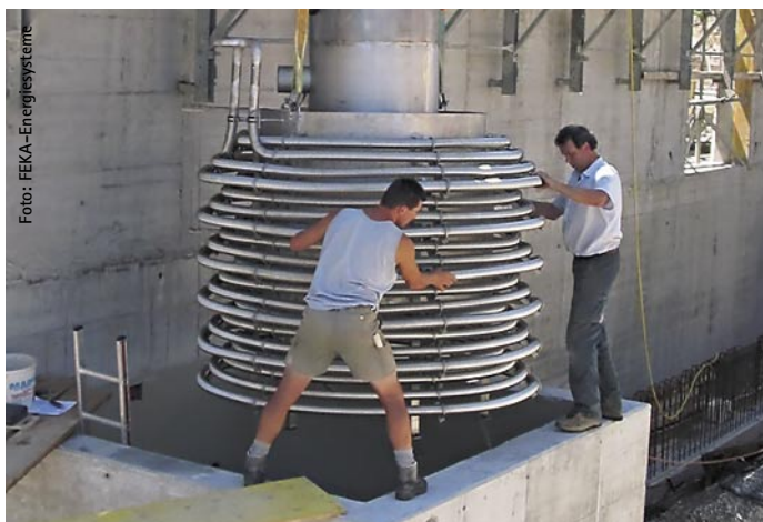
Bild 4 Einbau einer Abwasserwärmerückgewinnung mit Filter und Wärmeübertrager [FEKA-Energiesysteme]
