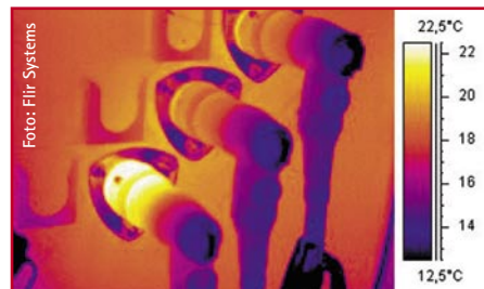
Bild 4 Lose Kabelverbindung
