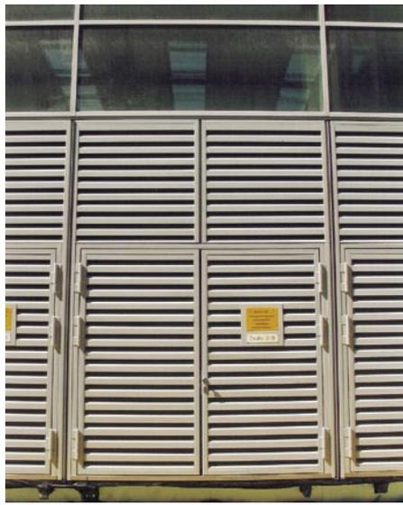
Messehalle in Düsseldorf: Die Ausbildung der Toranlagen mit Lärmschutzelementen berücksichtigt Schalldämpfung und Sabotagesicherheit
