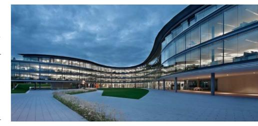
energiekonzept entsprechen dem Minergiestandard der Schweiz. Dazu tragen die Gesamtkonstruktion der Fassade, die Haustechnik und das thermoaktive System bei. Für die Heizung und Kühlung wird Seewasser genutzt. Im Speziellen werden die Anforderungen an Luftdichtigkeit,
